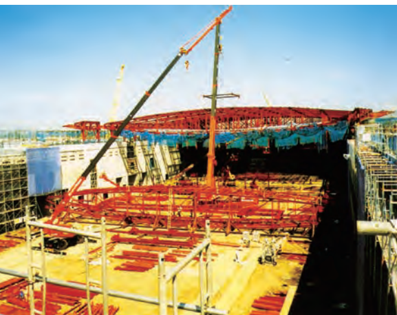
(1台組の取付) 橋本で組込んだ状態で吊り上げた後、現場で吊り込み、吊り込み後、現場で組立てる。
