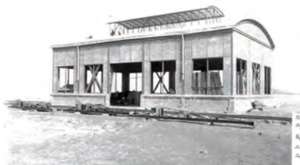
建設中の旧鍛冶工場
